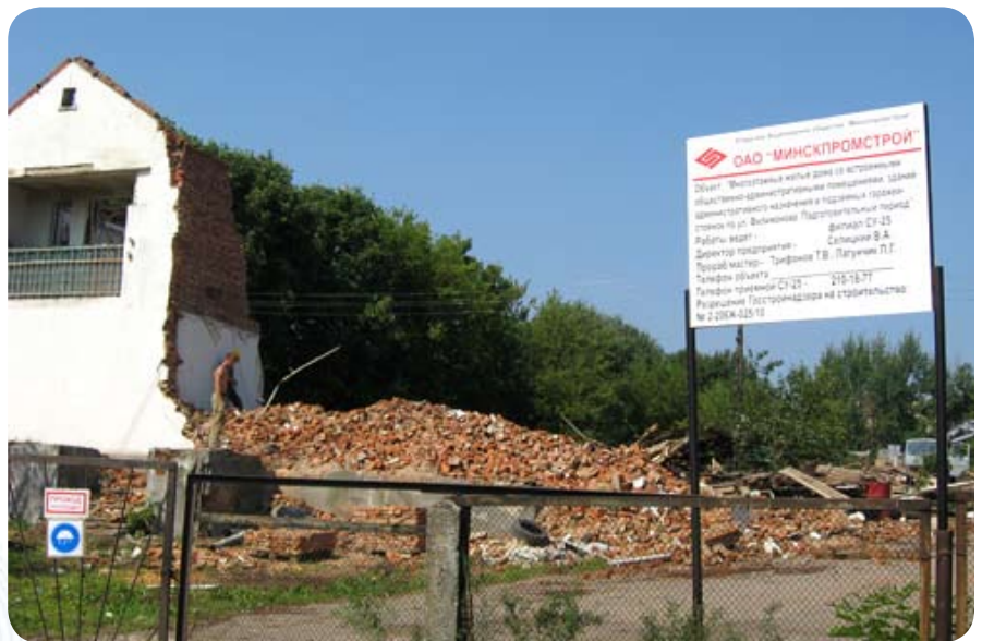
Так выглядел вход на стройплощадку 15 июня 2010 года
