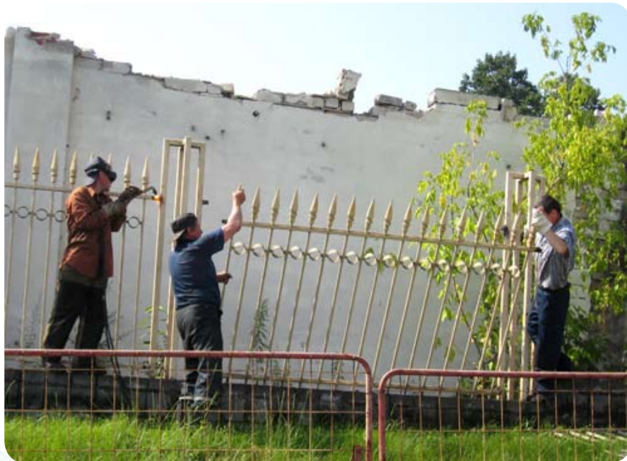
15 июня, рабочие автопарка №5 демонтируют забор на территории стройплощадки
