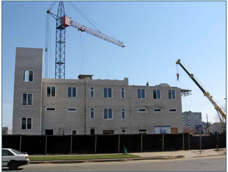
Контуры нового здания ЦБУ Белгазпромбанка в Барановичах уже вполне осязаемы
