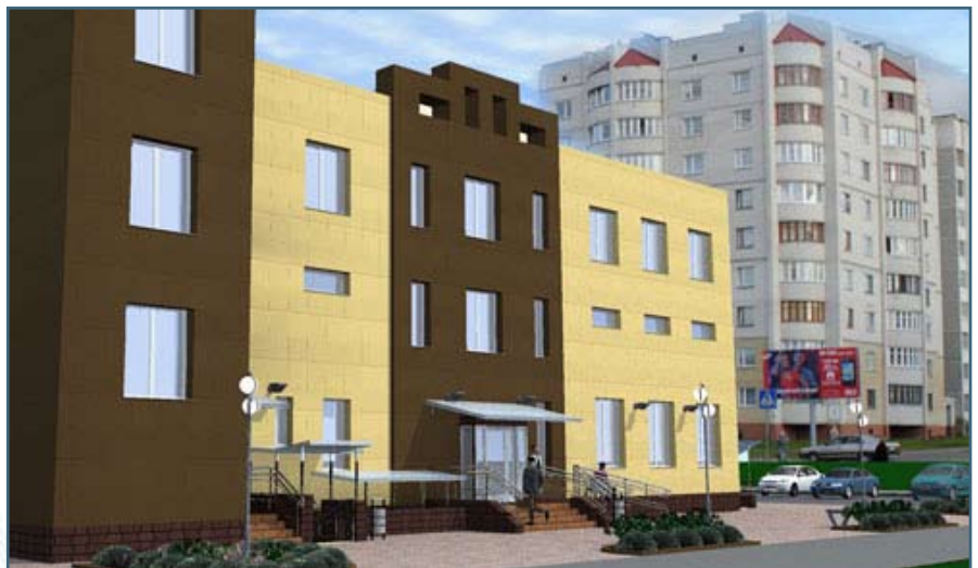
А так, планируется, оно будет выглядеть по окончании строительных работ
