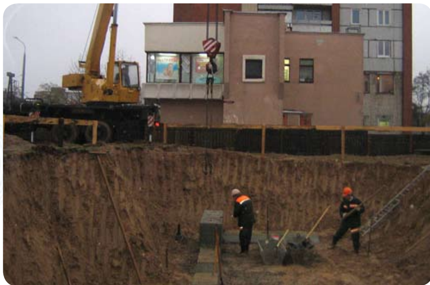
Закладка первого камня в фундамент нового здания, ноябрь 2008 года
